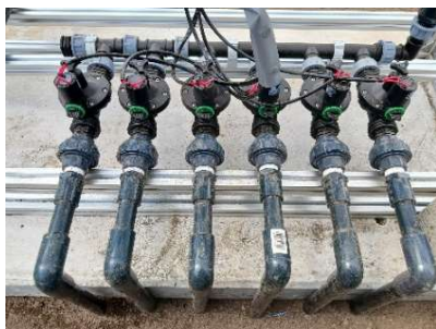
緩動電磁弁 2ITG 3/4" AC24V
