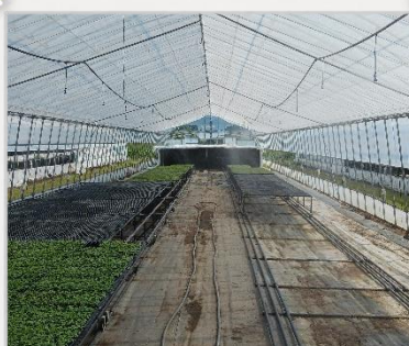
三石農業実験センター様設置例
