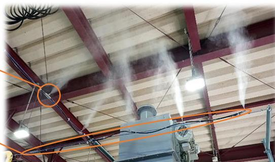
配管は専用のチューブを使用しており現場合わせし易く、施工性に優れています
