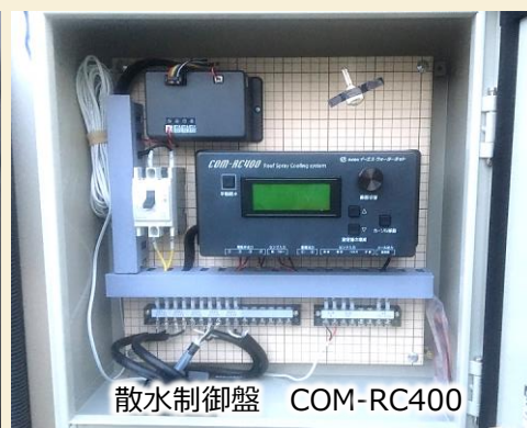
受水槽付ポンプ
