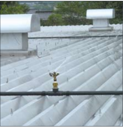
屋根散水 (王子製紙東京工場設置例)
