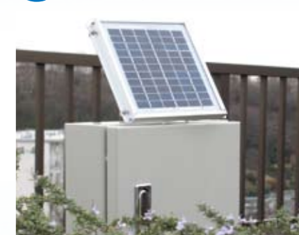
ソーラー式散水制御盤
