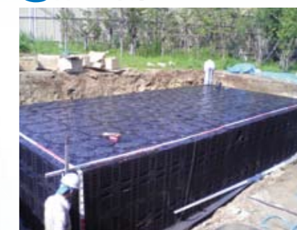
雨水地下貯留システム
