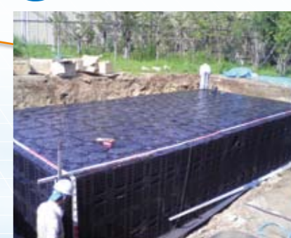
雨水地下貯留システム
