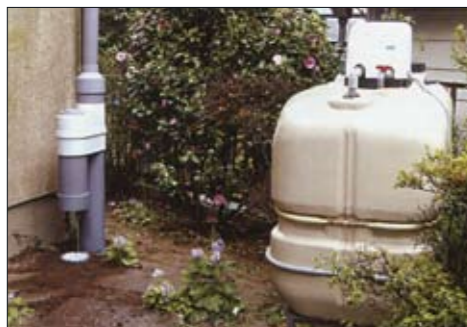
小規模向けの雨水貯留システムです。
