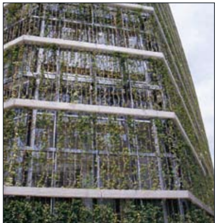
特殊チューブ、ミストノズル併用小量かん水例
