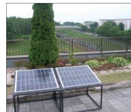
ビル屋上の緑化部分にかん水する際に、水は地下または地上の貯水槽に貯めた雨水を利用、貯めた水を屋上までくみ上げるための揚水用ポンプの電力は太陽光を利用するエコシステムです。
